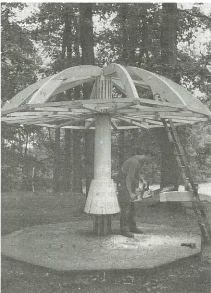
Sommer 2001 – ein neuer Hut entsteht
